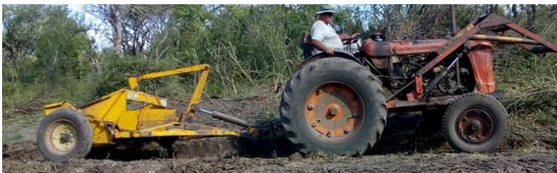
Ilustración 3: pala cargadora de arrastre, herramienta clave para trabajos de relleno y despeje de bajos (alcantarillas). Garantiza la no expansión de pozos en el camino que terminan desencadenando en pantanos.
