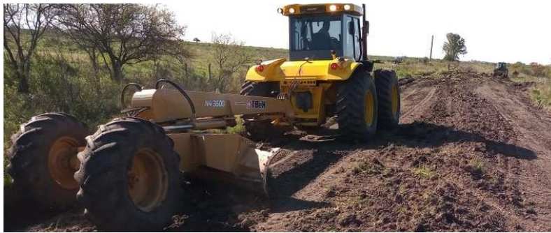
Ilustración 2: Niveladora de arrastre tipo N4 y tractor DT, siempre preferible antes que una motoniveladora. Brindan más días y horas de trabajo, aumentando la eficiencia y tiempo operativo, especialmente en temporadas de muchas lluvias.
